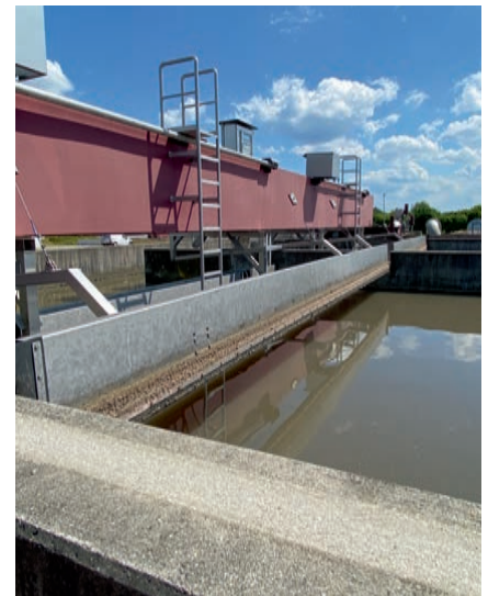
Bild 4: Schlammräumung (Bild: WAD GmbH)
