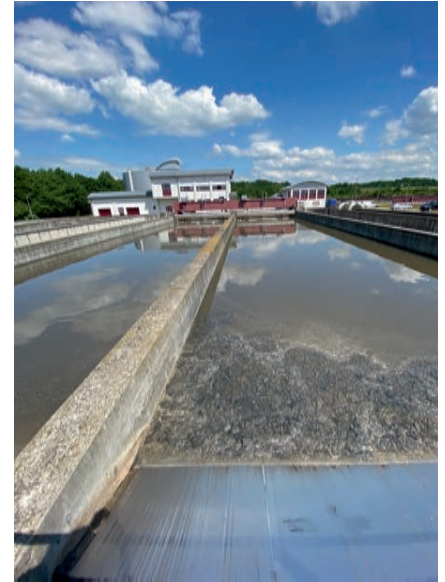
Bild 3: Schwimmschlamm, der regelmäßig entfernt wird (Bild: WAD GmbH)
