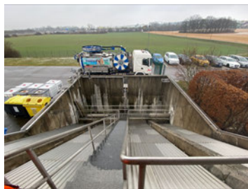
Bild 1: Das Rechenhaus in der Abwassertrensorgung (Bild: WAD GmbH)
